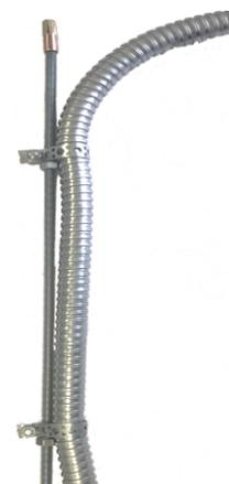
Рис 4.1.7 Спуск по шпильке при помощи перфорированной ленты
