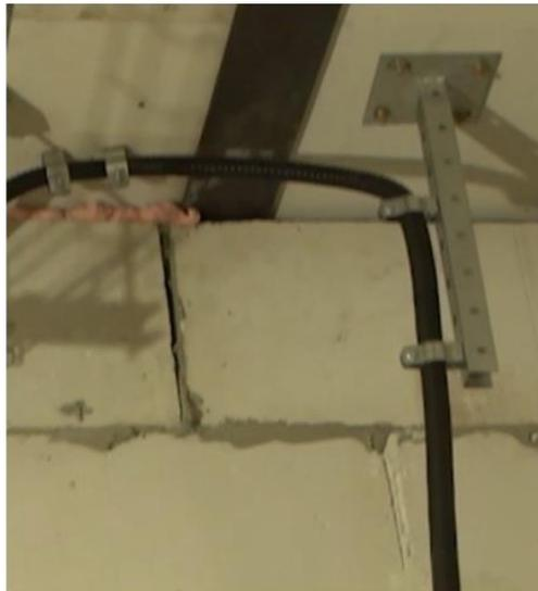
Рис.4.2.2 Организация спуска при помощи консоли
