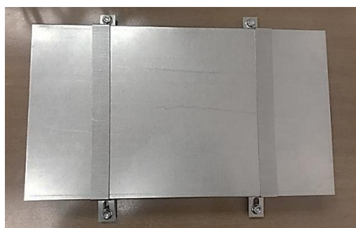
Рис. 17 Пример монтажа прижима крышки (вид сверху)
